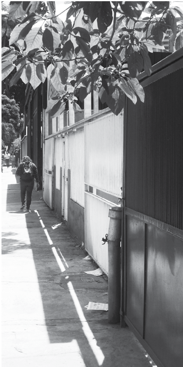
Figura No. 1. Aislamiento materializado a través del lindero. Fuente: Archivo personal del autor.
